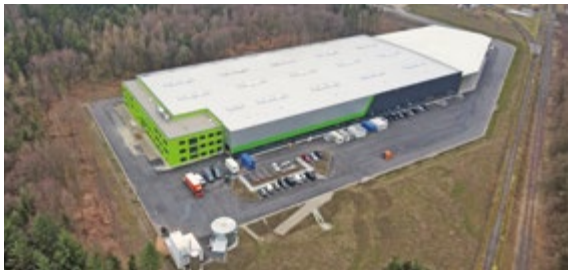
Komplette elektrische Installation durch die EKA: Das neue HAI-Logistikcenter mit Bürobereich und Überdachung.
