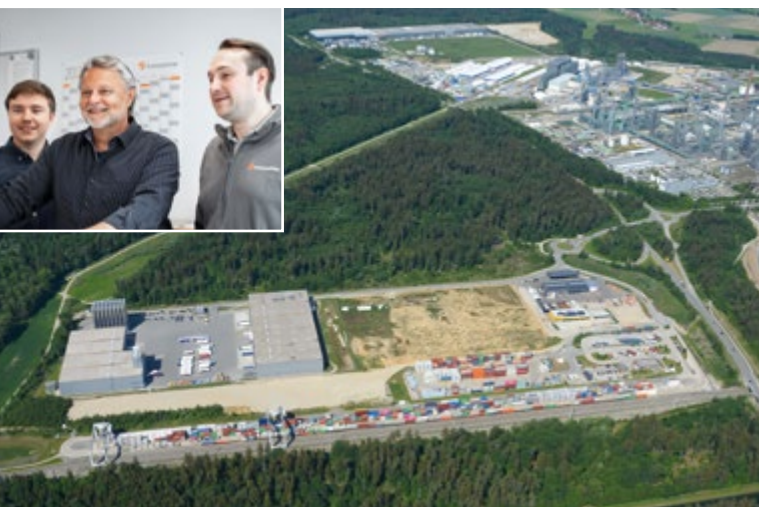
Neue Serverinfrastruktur für das KombiTerminal Burghausen eingerichtet: (v. li.) Project-Engineer Florian L., Koordinator Alexander R. und Christian A.
