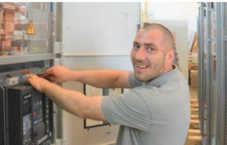
Schaltanlagenbauer Istvan Boros bei der Montage an einem der Hauptverteilerfelder für den iCampus München.
