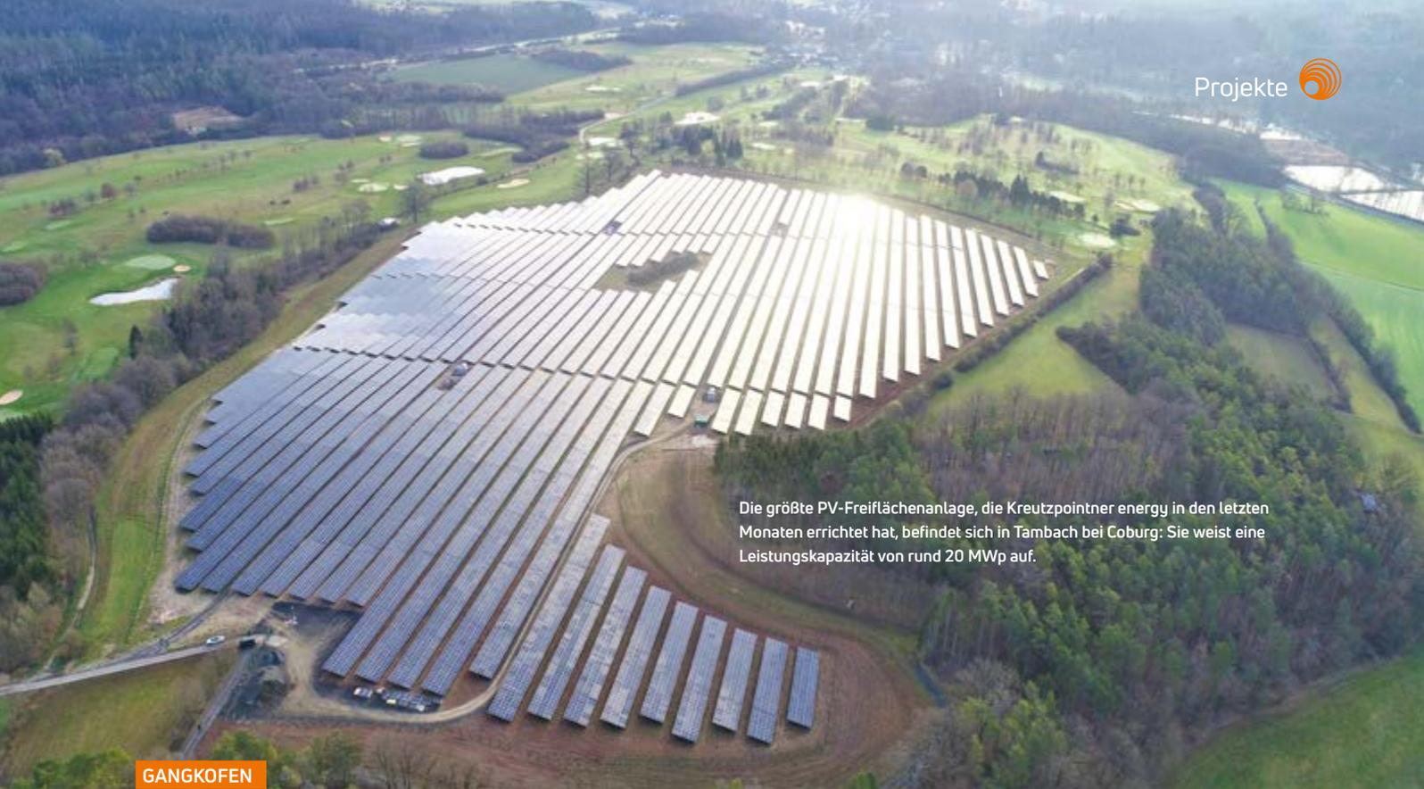
Die größte PV-Freiflächenanlage, die Kreuzpointner energy in den letzten Monaten errichtet hat, befindet sich in Tambach bei Coburg: Sie weist eine Leistungskapazität von rund 20 MWp auf.
