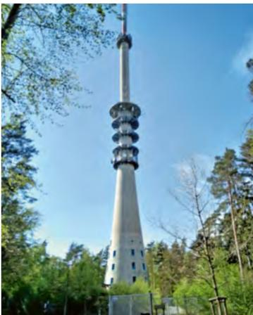
Der Sender Pfaffenberg (Bild BR) ist eine Sendeanlage des Bayerischen Rundfunks für UKW, Digitalradio DAB+ und digitales Fernsehen (DVB-T2) auf dem Pfaffenberg bei Aschaffenburg. Der Sendeturm ist rund 176 Meter hoch.
