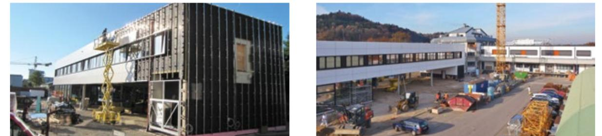
Ende September 2016: Die Fassadenelemente werden am Büroneubau angebracht. Rechts: Anfang Dezember 2016 war der neue Gebäudekomplex fertiggestellt, ebenso die Umbau- und Modernisierungsarbeiten am Flachbau des Altbestands.
