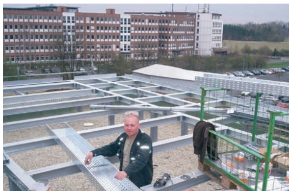
Kabeltrassenarbeiten bei einem der IBM-Rechenzentren-Projekte in Nürnberg.
