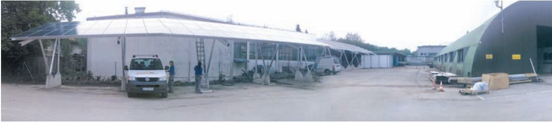
Modellcharakter mit praxisbezogenem Nutzen: Gegenüber der Rundbogenhalle ist Anfang Mai der neue Firmen-Carport mit PV-Anlage entstanden.
