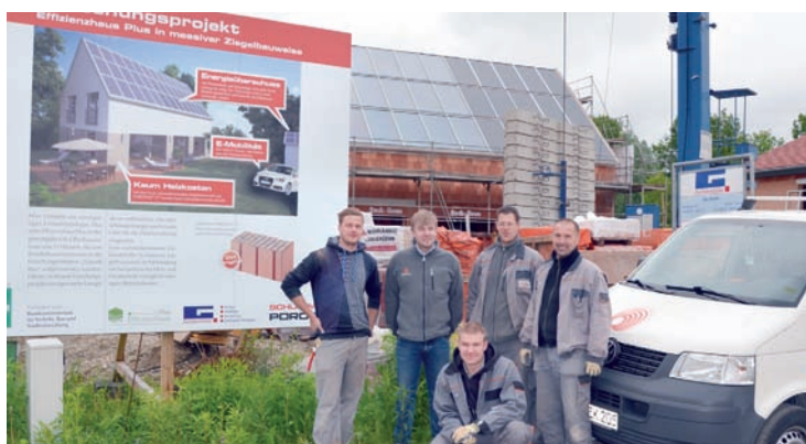
Das beim „Effizienzhaus Plus Schlagmann“ eingesetzte Gebäudetechnik-Team (von links) Benjamin Partum, Josef Auer, Michael Puchinger, Michael Madl und (vorne) Eugen Nazarenko.
