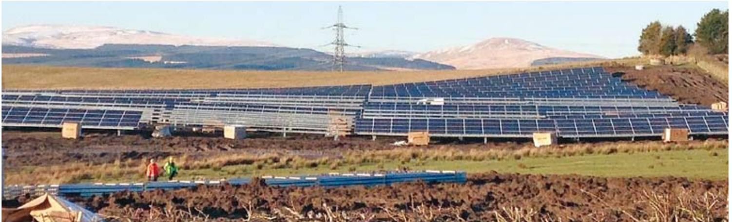
42.680 Module wurden im ersten Solarpark in Wales eingebaut – diese erzeugen seit 6. März 2015 rund 11,6 MWp Leistung.
