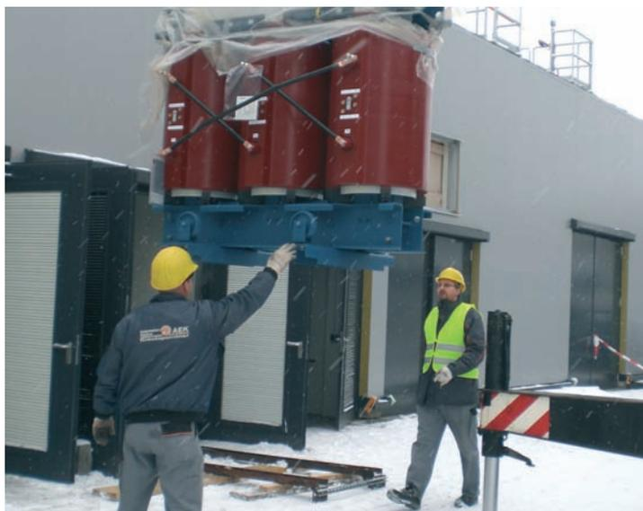
Michael Haferkorn und Olaf Kästner bei der Einbringung eines 1600 kVa-MS-Transformators in der Solar Factory III in Freiberg.
