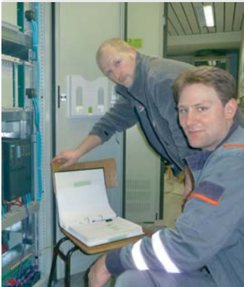
Projektleiter Jan Speer (li.) und Markus Brachinger beim Einbau von Schaltanlagen für die neue Leittechnik des Müllheizkraftwerks.
