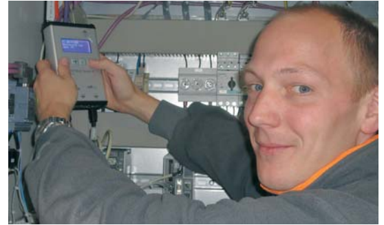
Alois Achleitner bei der Messung eines Profibus-Aufbaus im Schaltanlagenbau.
