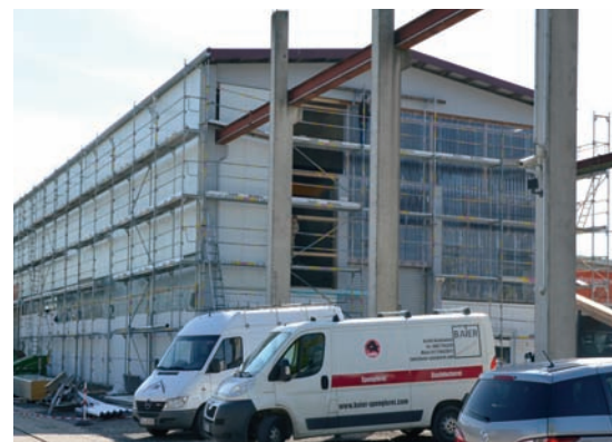
Eine neue 1.400 m 2 große Dachfläche sowie neue Seitenwände mit Fenstern hat das Gebäude des Schaltanlagenbaus in sechs Monaten Modernisierungsarbeit erhalten.
