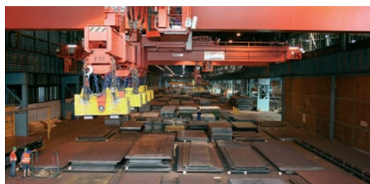
Gewaltige Dimensionen: Ein Hallen-Portalkran wie dieser wurde von der EKA bei der Voestalpine Grobblech in Linz elektrotechnisch modernisiert und umgerüstet.
