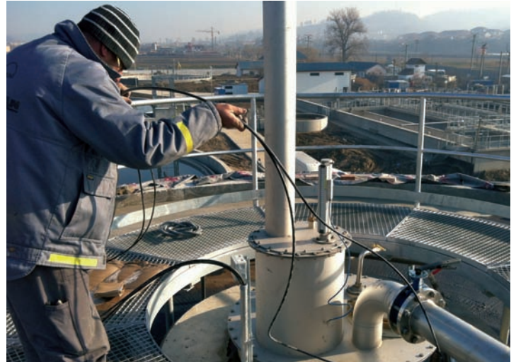
Noch im Dezember wird das Klärwerk in Mediasch in Betrieb gehen. Hier ein AER-Mitarbeiter bei Installationsarbeiten.
