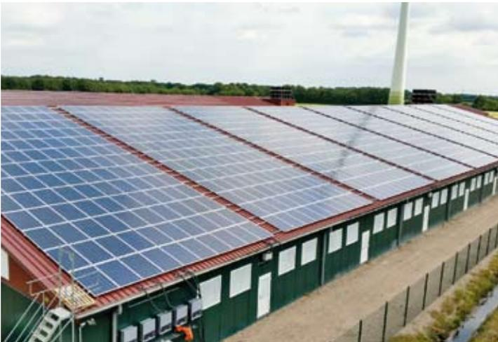
Im Juni und Juli montierte das energy-Team im Auftrag der NAVIS PV GmbH & Co. KG in Norddeutschland auf zwei Dächern eines neuen Schweinemastbetriebs eine 500-KWp-Dachanlage. 2.000 Stück PV-Module wurden installiert. Thorsten Scheck und Mario Wassermann führten den im mittleren sechsstelligen Eurobereich liegenden Auftrag als Bauleiter durch.
