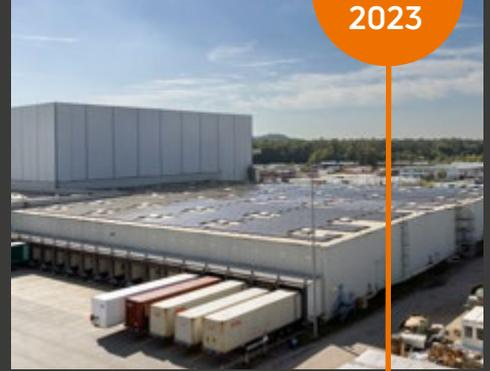
Auch im Industriebereich konnte Kreuzpointner energy erfolgreich Fuß fassen: Im Herbst 2023 errichtete man im Burghauser Wacker-Werk in nur siebenwöchiger Bauzeit eine PV-Dachanlage mit 1,5 MWp Leistung.
