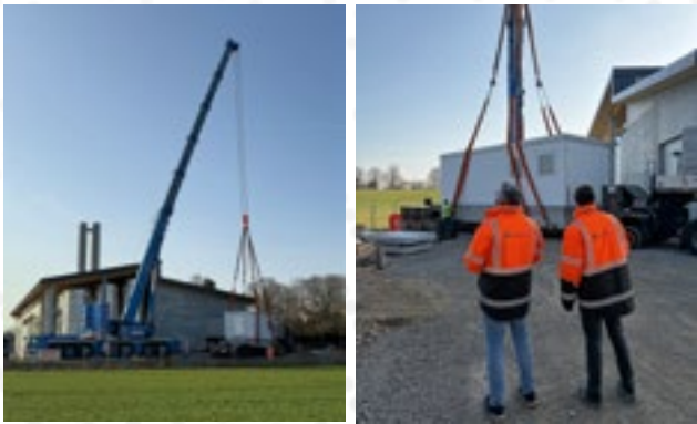
Planung und Ausführung für die Energieversorgung des Heizwerks von Strasslach-Dingharting mit kundenseitiger Trafostation. Rechts im Bild überwachen Andreas K. (li.) vom EFK-Schaltanlagenbau und Benedikt E. vom EFK-Engineering die Einbringung des Trafohauses.
