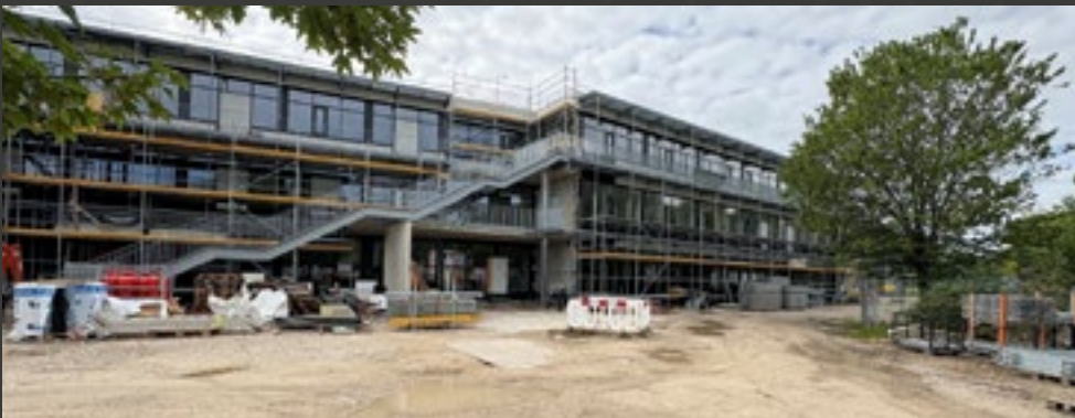
Tolles Einstiegsprojekt für Bauleiter Stefan K.: Das Elektroinstallationsprojekt im Neubau der CIC-School in München/Haimhausen.
