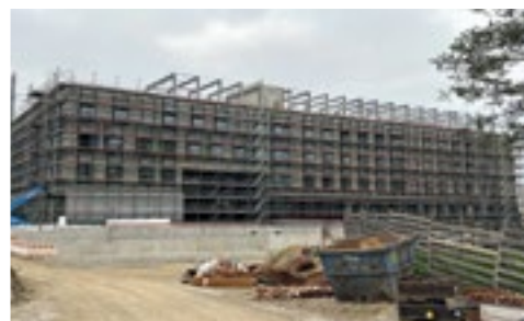
Bis Ende 2029 Baustelle für einen Mega-Auftrag der Kreutpointner-Gebäudetechnik: Aktuelle Ansicht der Klinik-Gebäudebaustelle „Neue Hauner“. Bild oben: Künftiges Aussehen eines Innenhofs von Europas modernster Kinderklinik.
